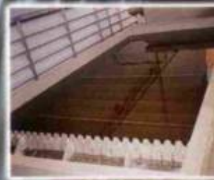
Clarificador lamelar contínuo em polipropileno
