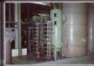
O Desmineralizador com regeneração automática
