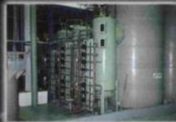
O Desmineralizador com regeneração automática
