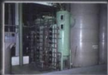
O Desmineralizador com regeneração automática
