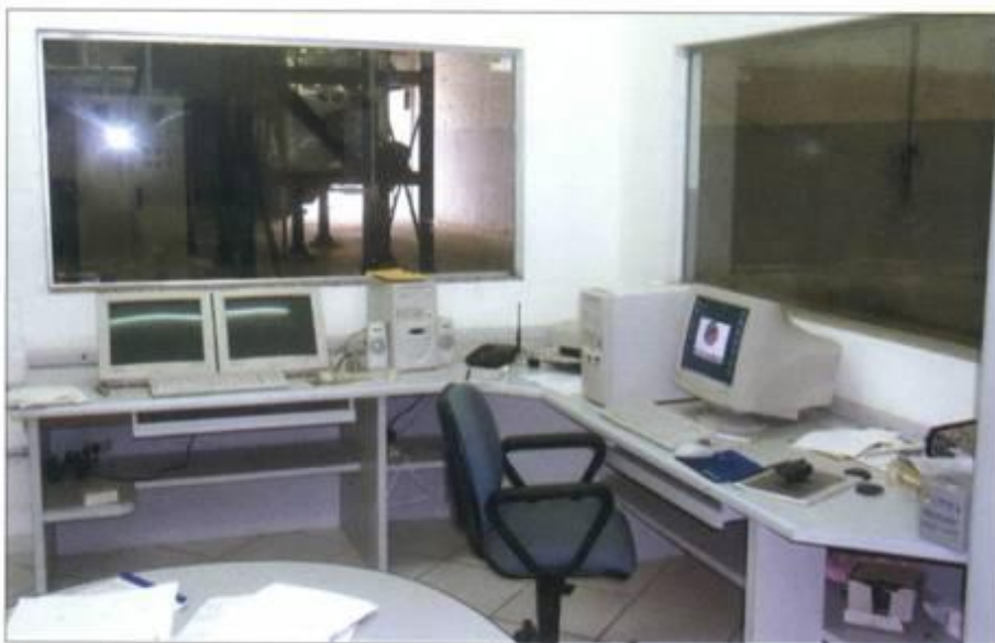
Controle é vital no tratamento de efluentes
