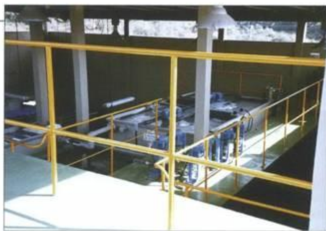
Reatores de tratamento com agitação mecânica
