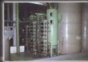
O Desmineralizador com regeneração automática
