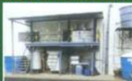
Estação de tratamento de efluentes por batelada
