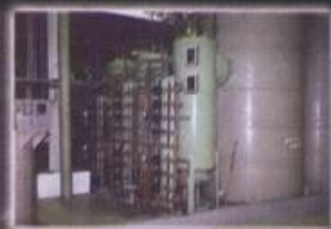
O Desmineralizador com regeneração automática
