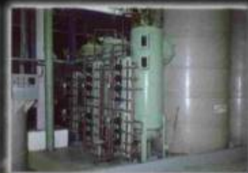
O Desmineralizador com regeneração automática
