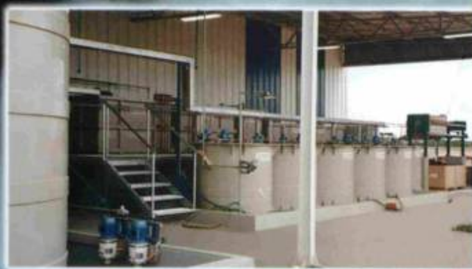
E.T.Es. para 10m³/h (fosfatização com pintura catódica)
