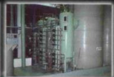
O Desmineralizador com regeneração automática
