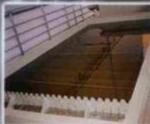
Clarificador lamelar contínuo em polipropileno
