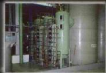
O Desmineralizador com regeneração automática
