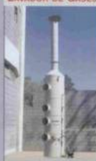
LAVADOR DE GASES
