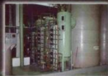
O Desmineralizador com regeneração automática
