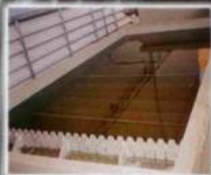
Clarificador lamelar contínuo em polipropileno
