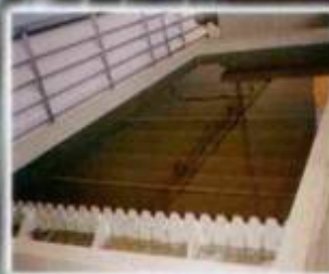
Clarificador lamelar contínuo em polipropileno
