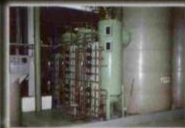
O Desmineralizador com regeneração automática
