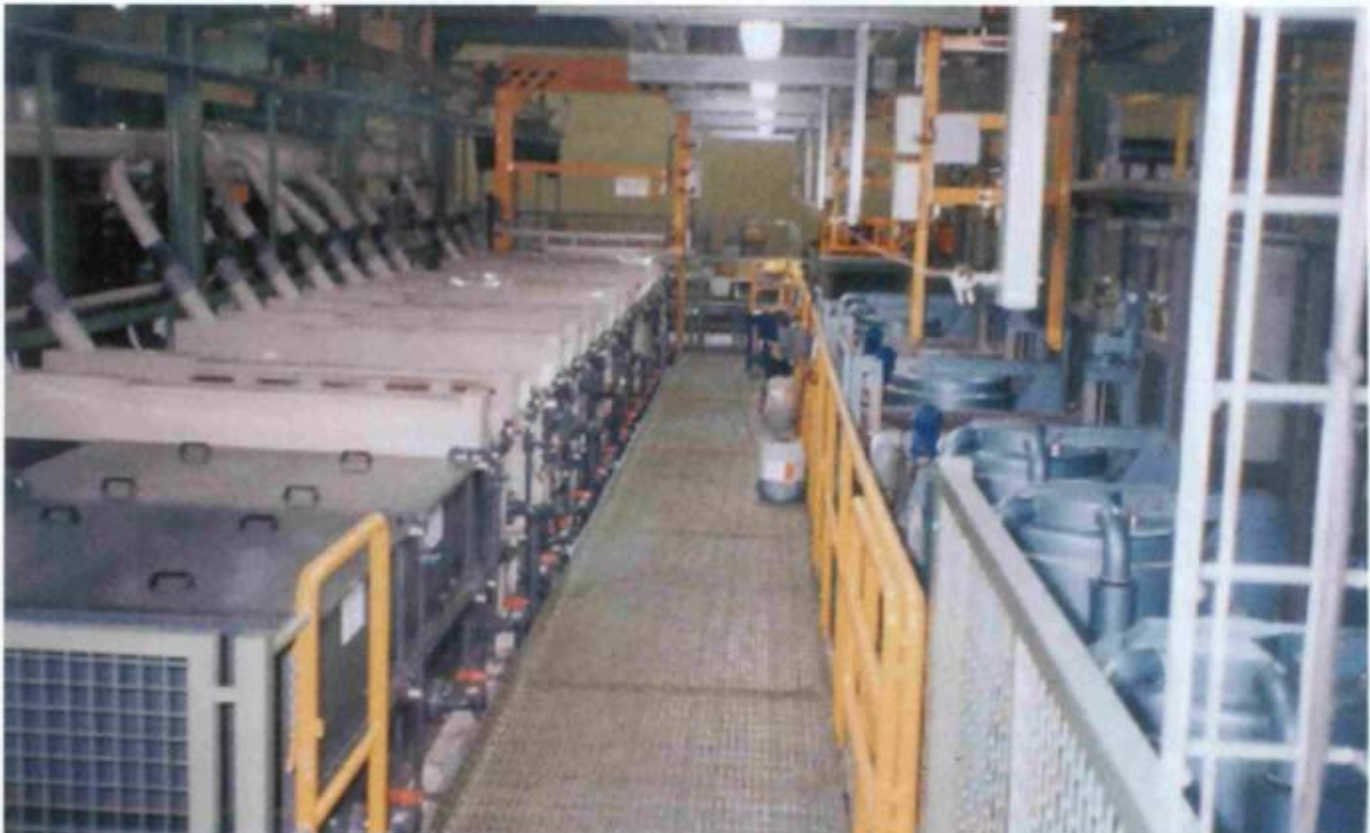
Linha completa de zinco + passivação + sealers totalmente automatizada
