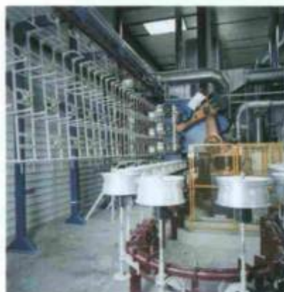
Transportador contínuo aéreo, transferência automatizada e "spindle conveyor"
