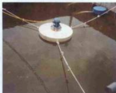
Figura 3 - Decantação no reator biológico
