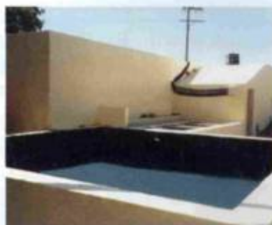
Figura 1 - Estação de tratamento biológico
