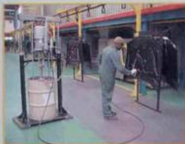
Aplicação de selantes a base de PVC
