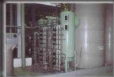
O Desmineralizador com regeneração automática
