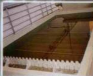
Clarificador lamelar contínuo em polipropileno
