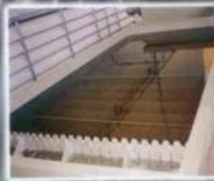
Clarificador lamelar contínuo em polipropileno
