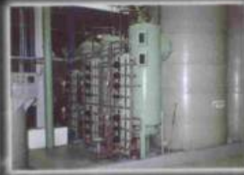
O Desmineralizador com regeneração automática
