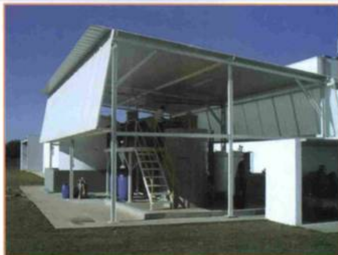
Estação de tratamento de efluentes
