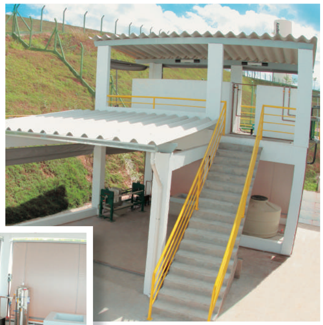
Estação de Tratamento de Efluentes
