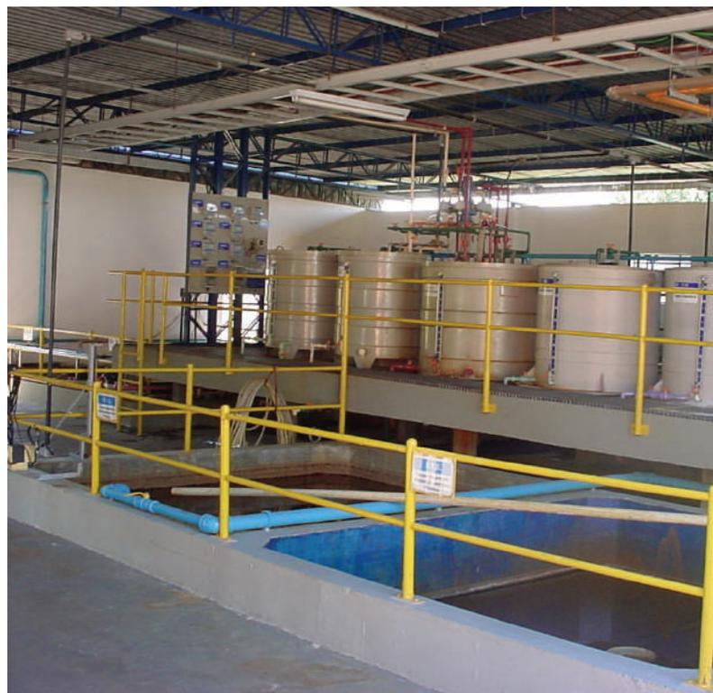
A Enasa fez a implantação de sistema de tratamento de efluentes galvânicos em fabricante das estruturas
