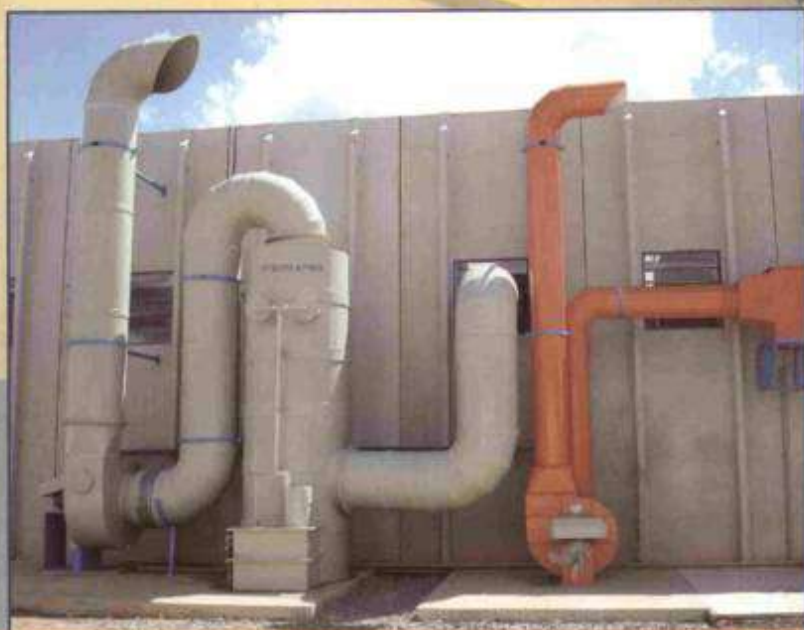
SISTEMA DE LAVAÇÃO DE GASES E FILTRO DE CROMO
