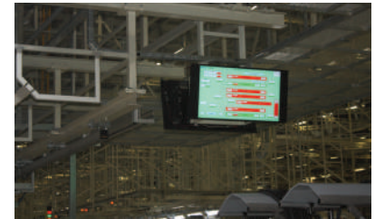
Figura 5: Grandes monitores dão informações para as equipes de montagem
