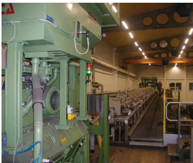
Visão geral de uma linha antes da seção de fosfatização eletrolítica
