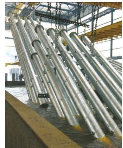
Figura 4 - Peças passando pelo tanque de passivação
