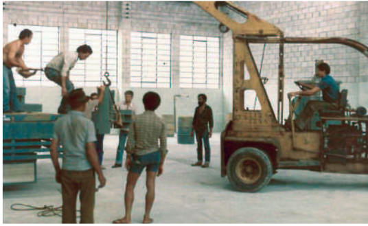
Montagem da fábrica, no município de Taboão da Serra
