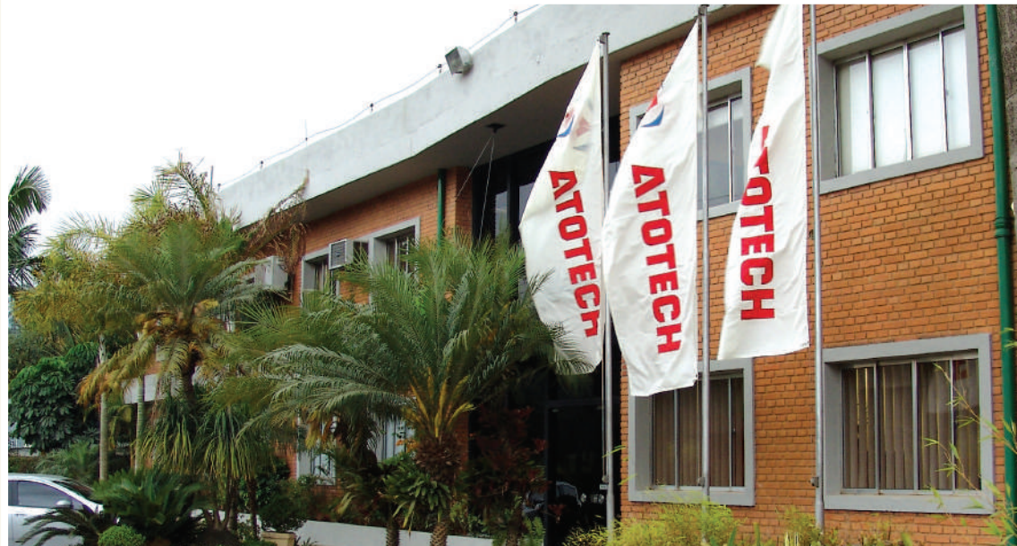
Em 1999, a Atotech ampliou suas instalações, adquirindo o prédio onde está localizada hoje
