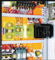
Sistemas de controle com cartões eletrônicos tipo "Euro-card plug-in" facilitam a instalação
