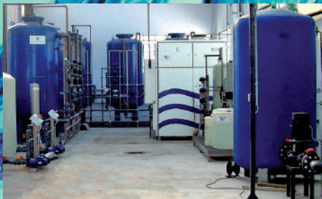
REUSO DE AGUA COM DESCARTE ZERO PARA LINHA DE ANODIZAÇÃO DE ALUMÍNIO
