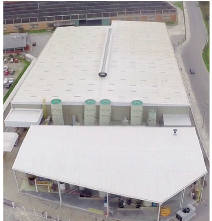
Nova unidade Galvânica e Estação de Tratamento de Efluentes Divisão Construção Civil | Farroupilha - RS
