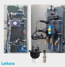
Painel com as sondas de leitura e válvulas de purga:
