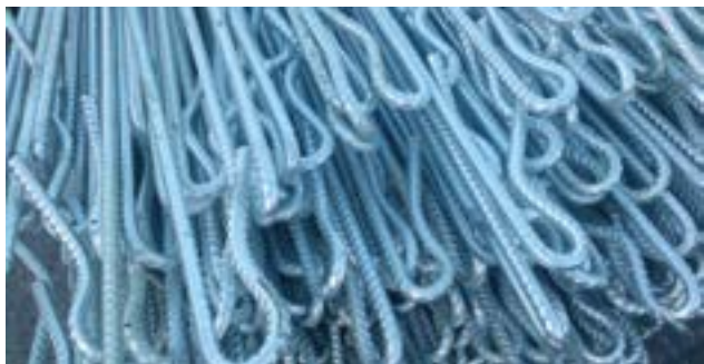
Figura 4: Barras galvanizadas no canteiro de obras
