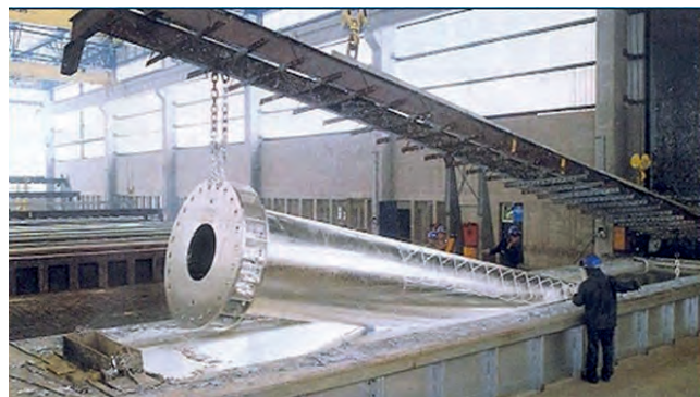
Processo de galvanização a fogo por batelada
