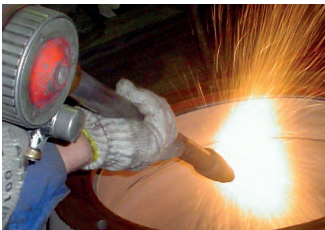
Recuperação interna de mancal por metalização a chama com extensão
