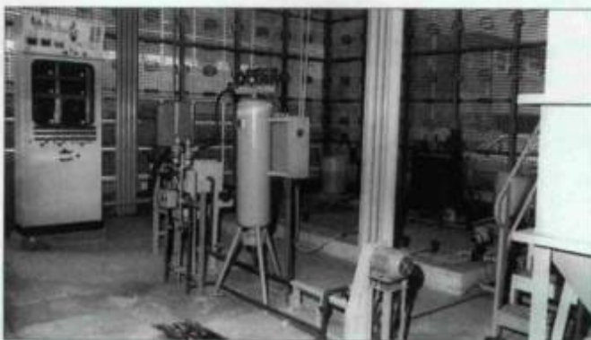
Instalações da Escola em São Bernardo do Campo.
