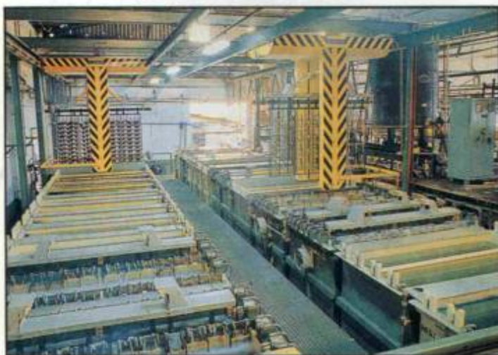
Instalação automática de GALVANOPLASTIA, SEM USO de fabricação ELMACTRON.
