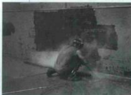
Hydroblasting sendo utilizado na remoção de tinta e ferrugem
