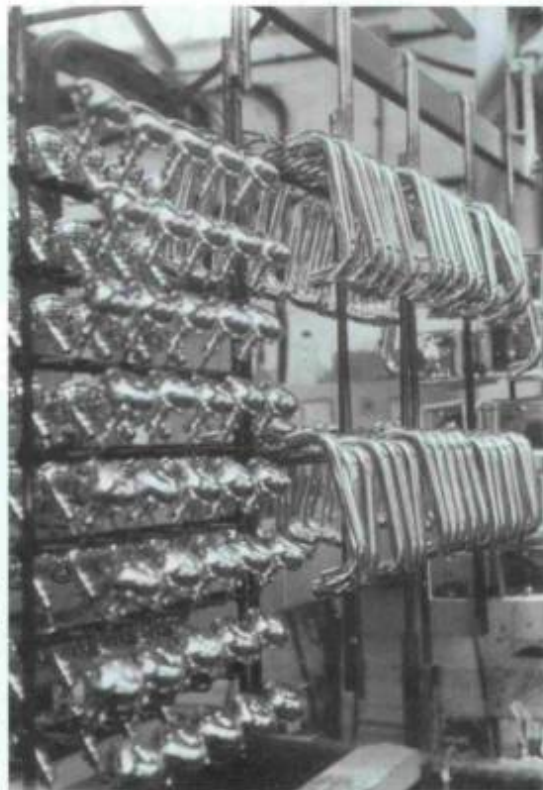
Instalação de Eletrorevestimento da SPS
