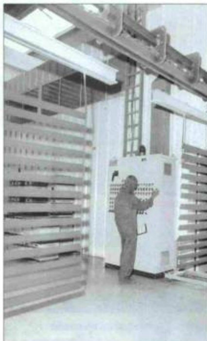
Cabina de Pintura a pó
