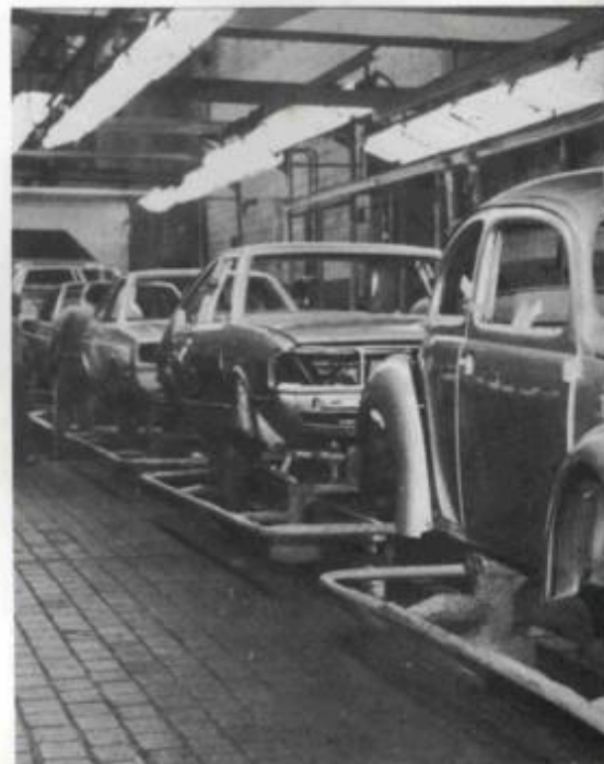
Saída da estufa de esmalte. Zona de acabamento
