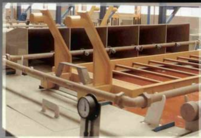
Exaustão tipo "push-pull"
