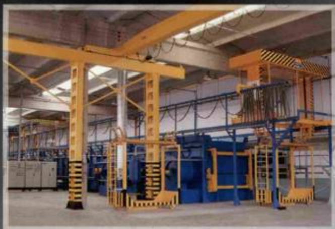
Transportadores enclausurados e com sistema de nebulização
