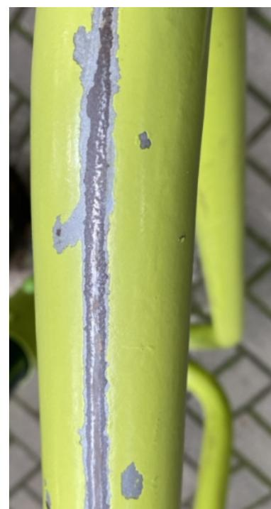
Figura 2, A e B (real): Proteção catódica sob a tinta
