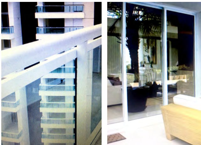
Guarda-corpo em sacadas e esquadrias montadas
