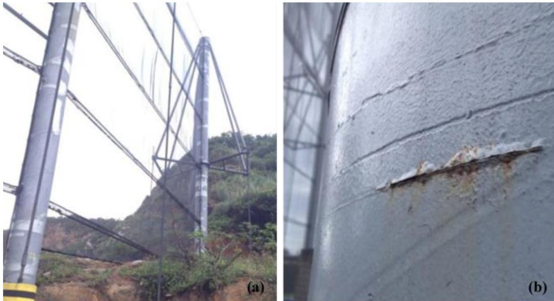
**Figura 5 - Inspeção Visual em 2014: (a) Torre Galvanizada e (b) Torre pintada.**
