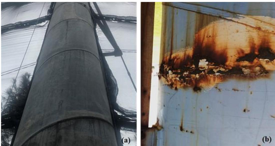
**Figura 6 - Inspeção Visual em 2019: (a) Torre Galvanizada e (b) Torre pintada.**
