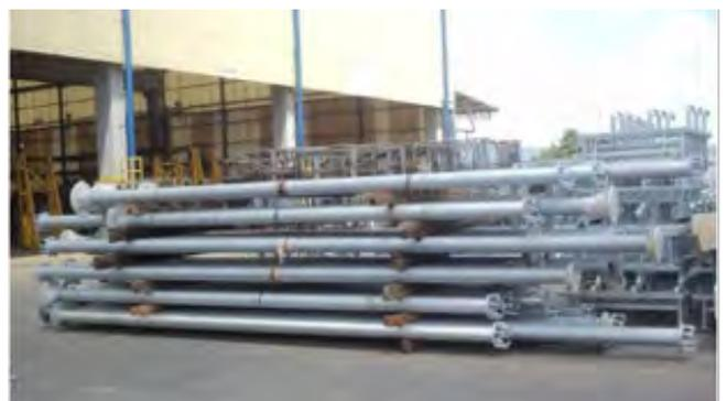
Foram utilizadas mais de 80 toneladas de vergalhão galvanizado para o concreto armado e 37 colunas em aço galvanizado, para sustentação da laje que simula uma marola.
