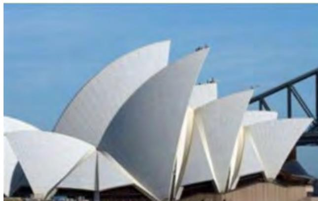
O trabalho começou em 1958, e o teatro foi aberto em 1973. Conchas de concreto pré-moldadas reforçadas com malha de arame galvanizado, sem corrosão por 42 anos.
