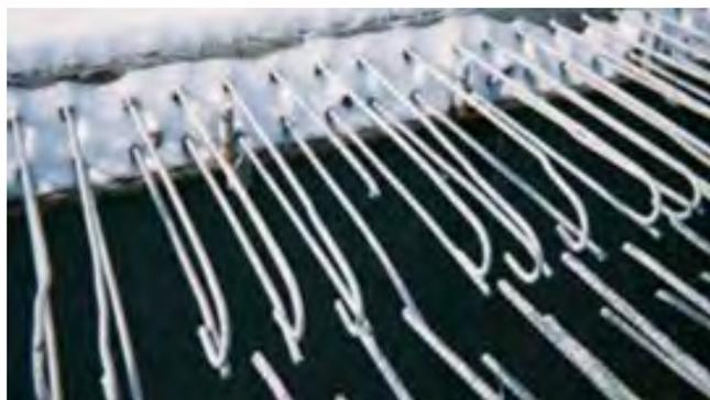
Construída em 1973, mesmo após 30 anos de exposição a altas concentrações de cloreto não houve evidência de corrosão apesar do teor de cloreto encontrado na superfície ser 5x o limite de corrosão para a moldura nua.
