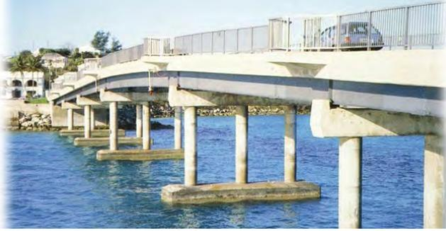
Construída entre as ilhas Somerset e Watford, nas Bermudas, a ponte foi erguida, em 1982, com vigas de aço estrutural galvanizadas apoiando um deck de concreto armado totalmente galvanizado.
