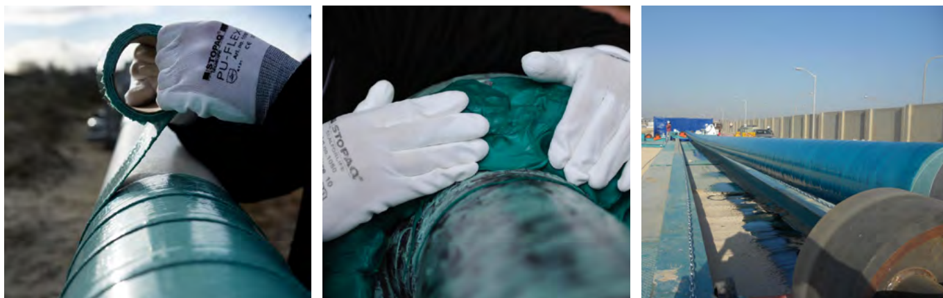
Quadro 8 - Aplicações do sistema de revestimento base PIB em dutos, válvulas e estacas
