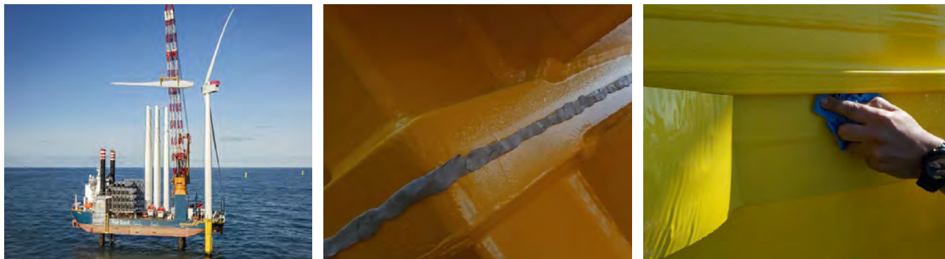
Quadro 1 - Revestimento com produtos à base de PIB em turbinas de energia eólica.
