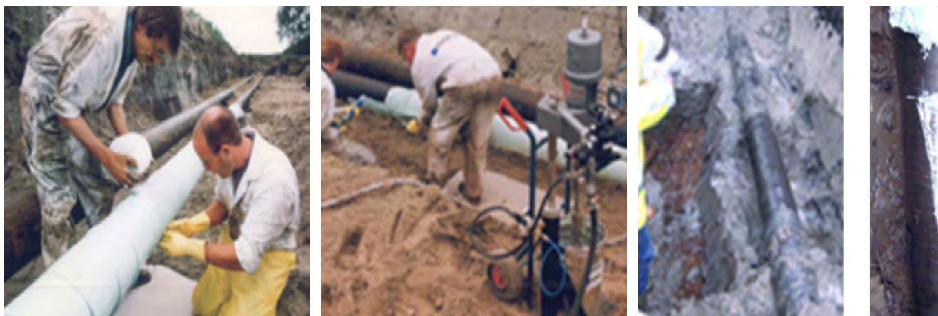
Quadro 7 - Revestimento à base de PIB aplicado a um gasoduto (primeiros ensaios de campo) em Duurswold, Holanda. As duas imagens à esquerda: aplicação manual, utilizando uma bomba, executada em 1996. As da direita: escavação e inspeção em 2003: sem sinais de corrosão.
