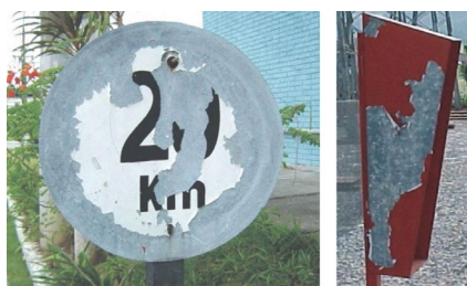
Painéis galvanizados e pintados, apresentando destacamentos da tinta
