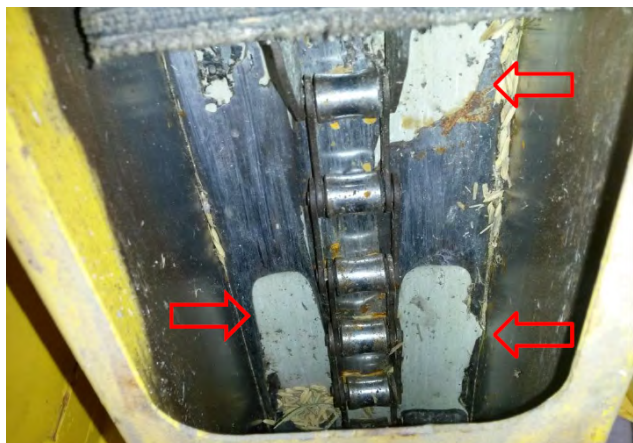
Foto 10 - Desgaste no elevador de retrilha [Ref. 7.m]
