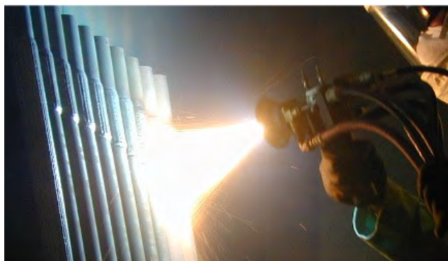
Foto 7: Aplicação através de equipamento na cogeração de energia [Ref. 7.j]
