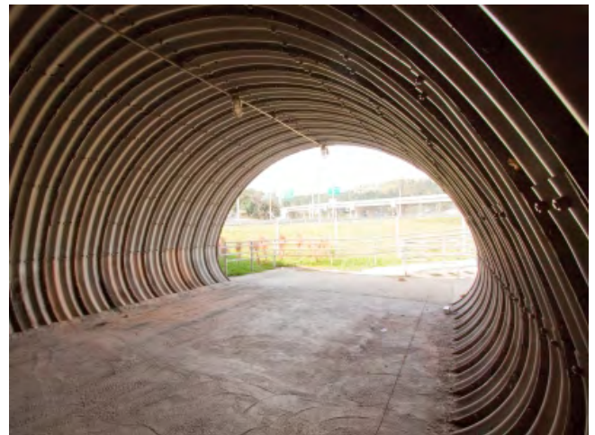
Figura 14: Túnel para passagem de veículos.
