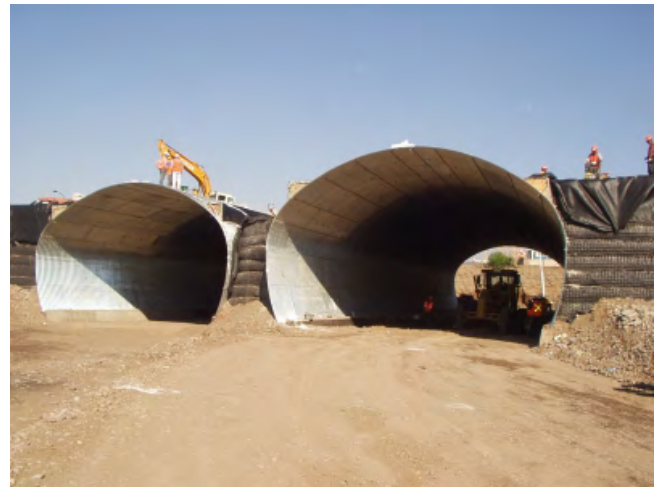
Figura 13: Canalização de córregos e rios.
