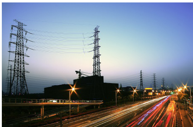
Figuras 3 A, B e C: Torres em aço galvanizado pintado
