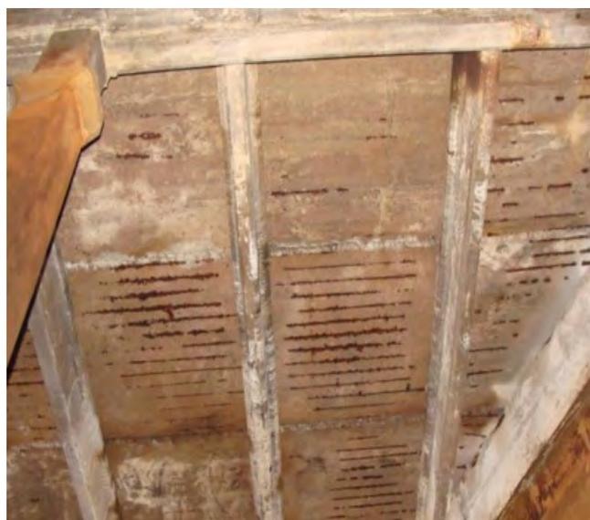
Figuras 10 e 11: Corrosão dos vergalhões na laje de concreto de reservatório de tratamento de água.
