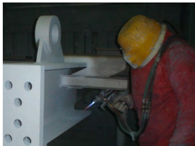
Foto 3 - Metalização de estrutura de nacela [Ref. 10.m]
