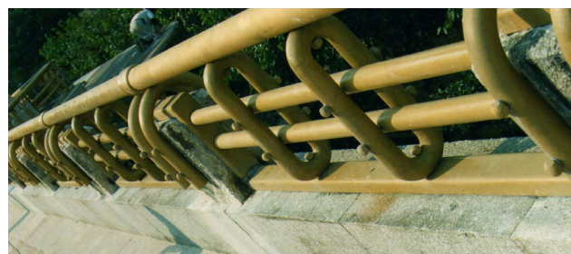
Foto 8 - Estrutura instalada [Ref. 10.o]
