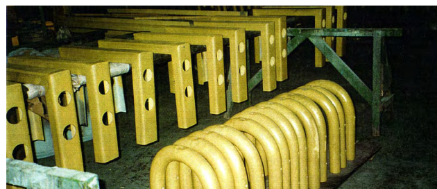
Foto 7 - Estrutura desmontada metalizada
